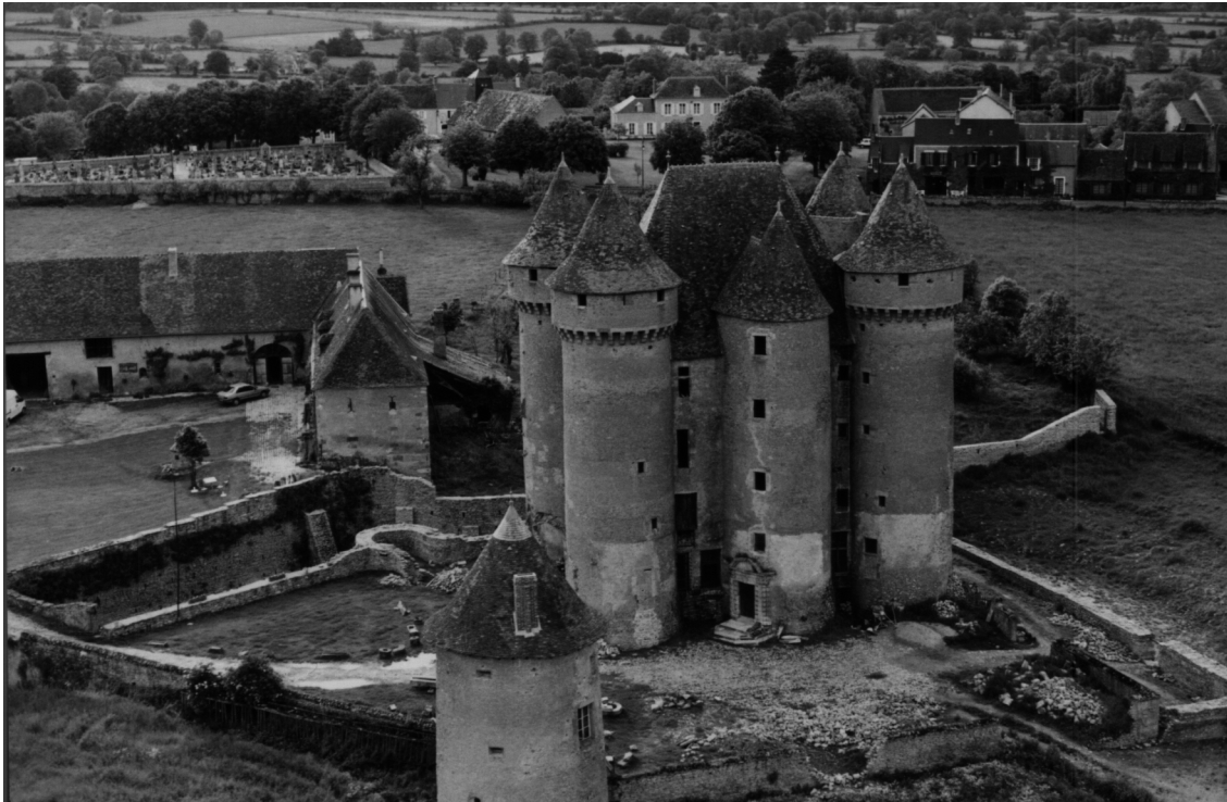
Vue du donjon sur sa face Est avec au premier plan la Tour Chapelle
